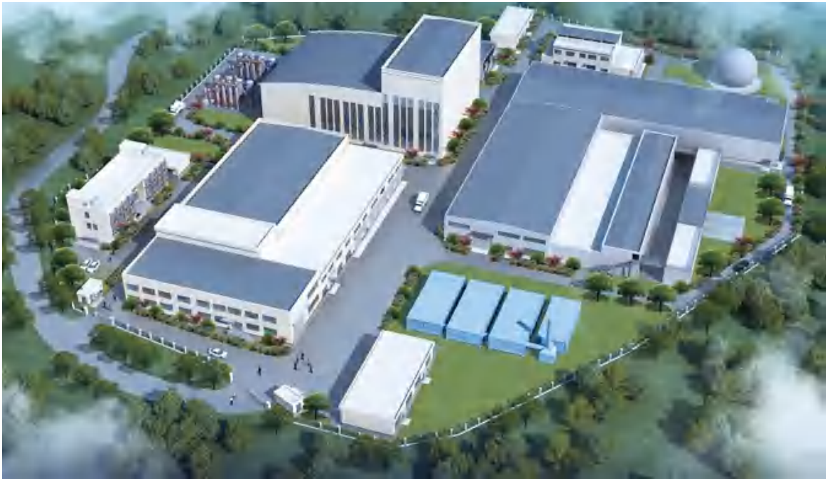
▼ 庆元生活垃圾综合处理处置项目，处理规模生活垃圾200t/d，餐厨垃圾和粪便20t/d，工厂废弃物（非危废）15t/d。
